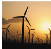
Výroba elektrické energie
